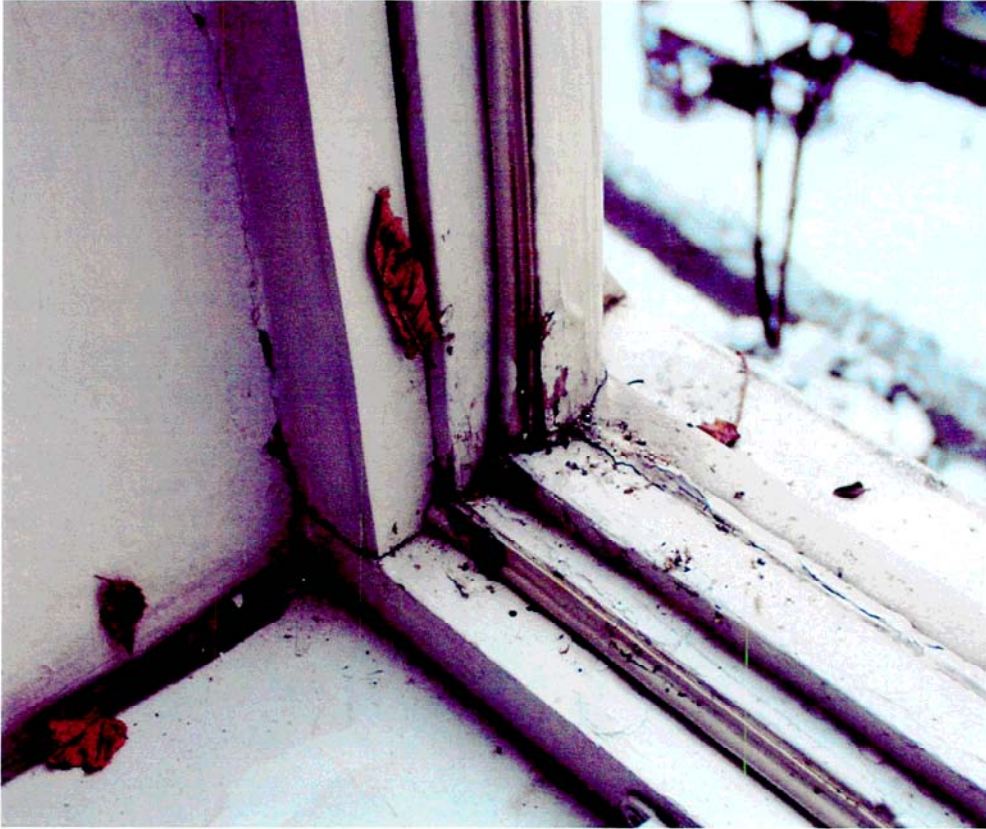
Fensterphoto 1+2: Raum 3; dasselbe Fenster vor + nach dem Streichen, Innenhofseite. Allein ein Anstrich hat alle Mängel überdeckt!
