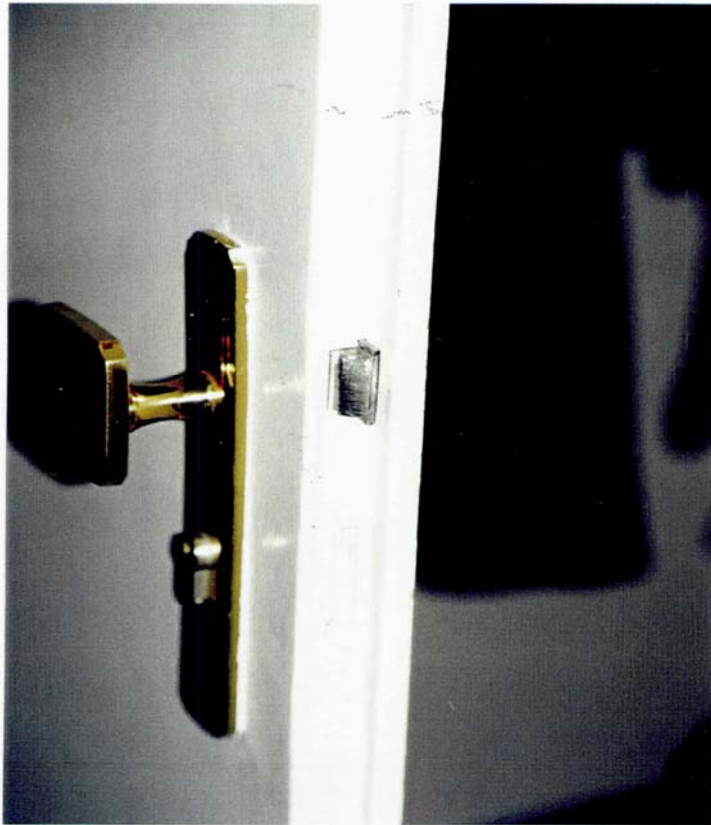
Bild 31 Flurtüre Pacellistr. 8, vorstehender Zylinder
