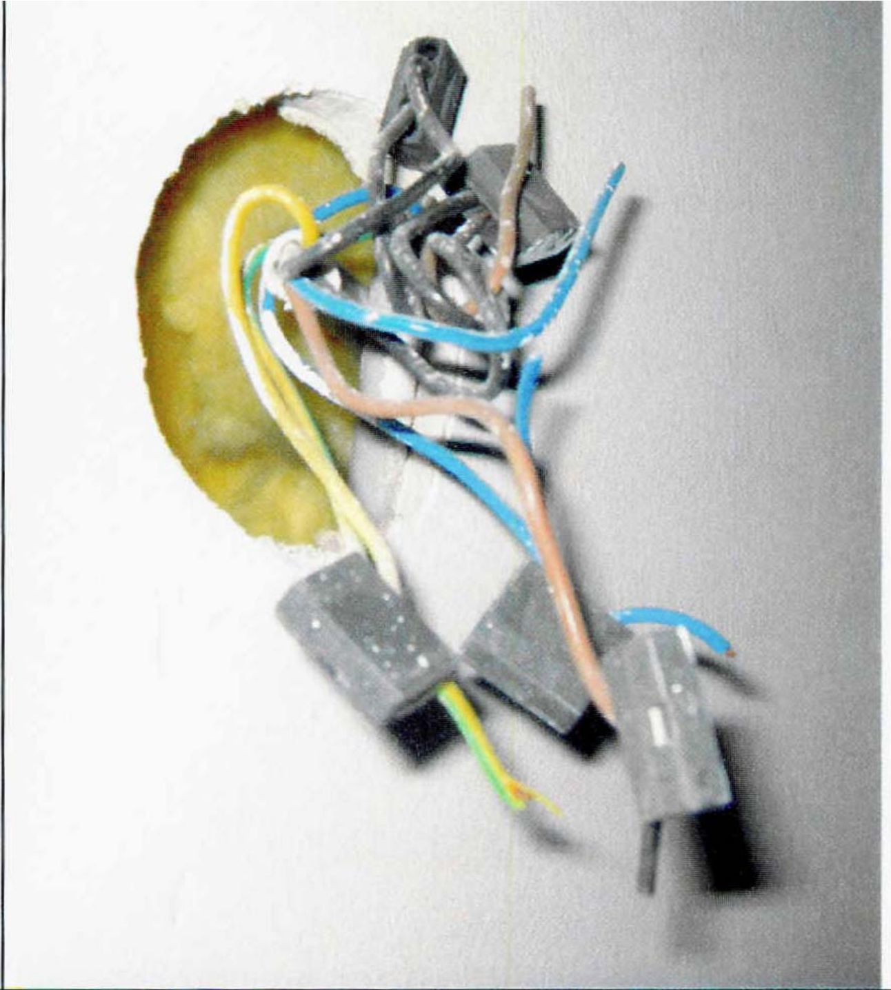
Photo: Gerichts-SV Dr. Kersken-Bradley aus Gutachten vom 01.08.2004 für 5 U 5268/02 Ausschnitt aus der in der Kartonagenwand untergebrachten Elektroinstallation
